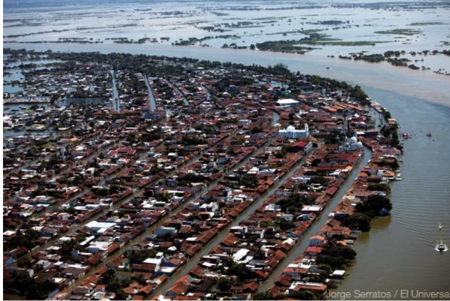
Figura. A-43.-Vista de Tlacotalpan inundada al paso del huracán Karl (El universal, 2010)
