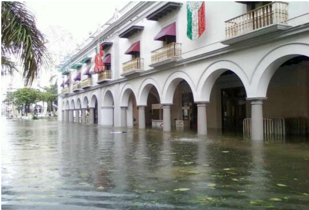
Figura. A-42.- Edificio del ayuntamiento de Veracruz inundado (Letiitta , Twitter).
