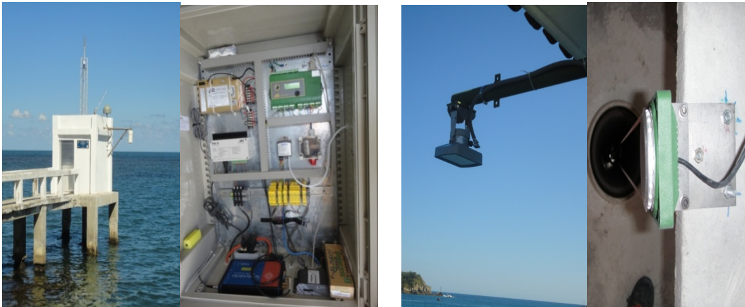
Figura 23. (Izq.) Estación mareográfica de Veracruz del tipo GLOSS con equipo de transmisión y datalogger; (Der.) Mareógrafo de radar cuya pantalla apunta al espejo del agua y rueda codificadora de mareógrafo de flotador digital (Felipe Hernández Maguey, Archivo historico del SMN).
